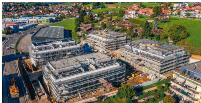
Construction de 102 appartements avec parking souterrain – PPE La Fontaine à Châtel-St-Denis. Années de construction: 2020 - 2022.
